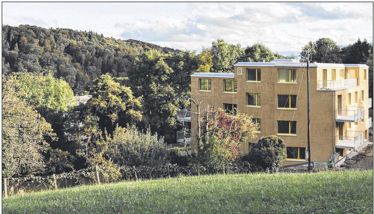
C'est une première européenne. Cette maison, à Zurich, est exempte de tout matériau susceptible de causer des allergies. DR
