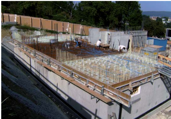
Die Glasfaserbewehrung Combar der Schöck Bauteile AG erfüllt mehr als alle Bedingungen des Bewehrungsstahls und weist dabei ein elektromagnetisch neutrales Verhalten auf.
