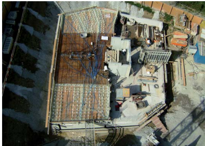
Das MCS-gerechte Wohnhaus in Zürich-Leimbach ist ein europaweites Pionierprojekt. Material und Konstruktion erforderten einiges an Tests und Vorabklärung.
