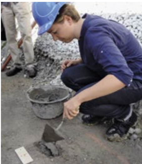
07 Bei der Grundsteinlegung nach alter Bauhüttentradition wurden als Massnahme zur «Entstörung» äusserer Einflüsse vor dem Betonieren an den Gebäudeecken Bruchstücke eines Steins in die Magerbetonschicht eingefügt. Die an der Zeremonie beteiligten zukünftigen Bewohner wussten den zusätzlichen psychologischen Effekt dieser positiven Absichtserklärung sehr zu schätzen. (Foto: Christian Schifferle)
